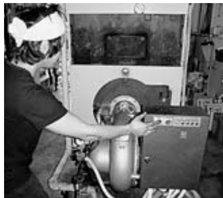
ボイラー機械の点検
