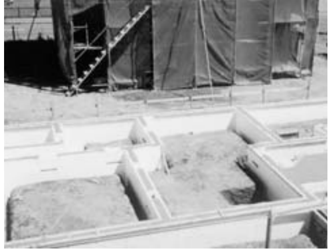
発泡スチロール製打ち込み型枠
